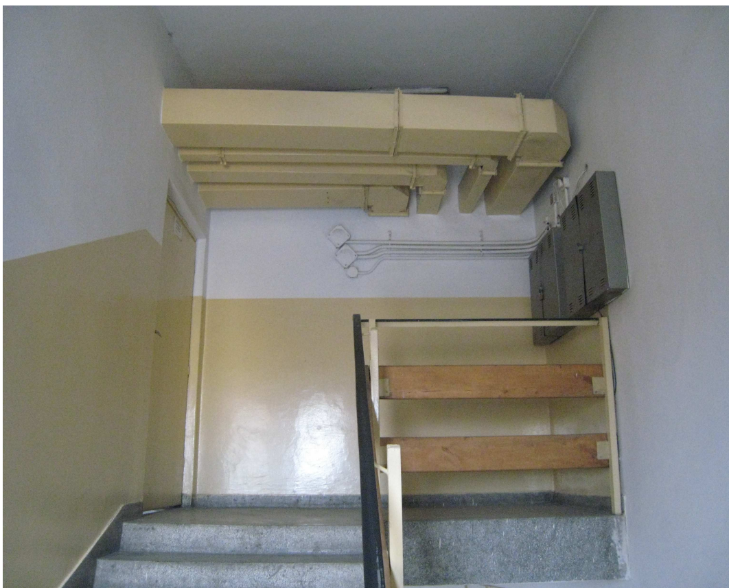
Zdjęcie Nr 3. Kanały z wentylatorowni nad 4 piętrem.przechodzące przez ściany p.poż. do zabezpieczenia
