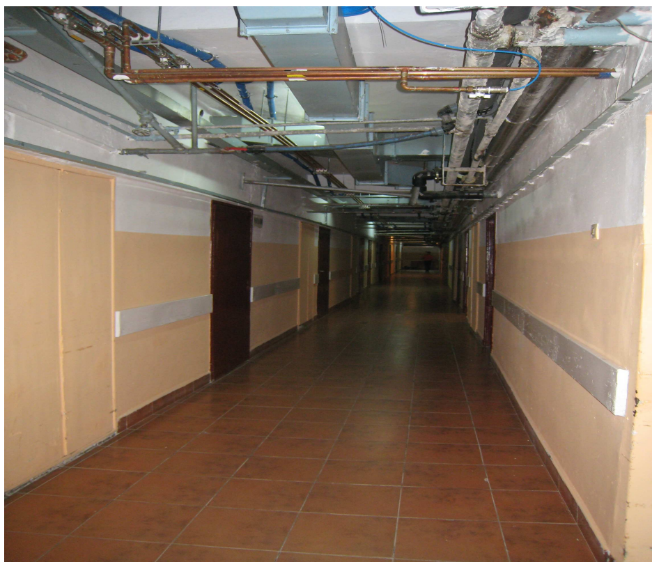
Zdjęcie Nr 4. Przewody i kanał wentylacyjny do zabezpieczenia przechodzące przez nowoprojektowaną ścianę p.poż. w piwnicy wg rys. A-11.
