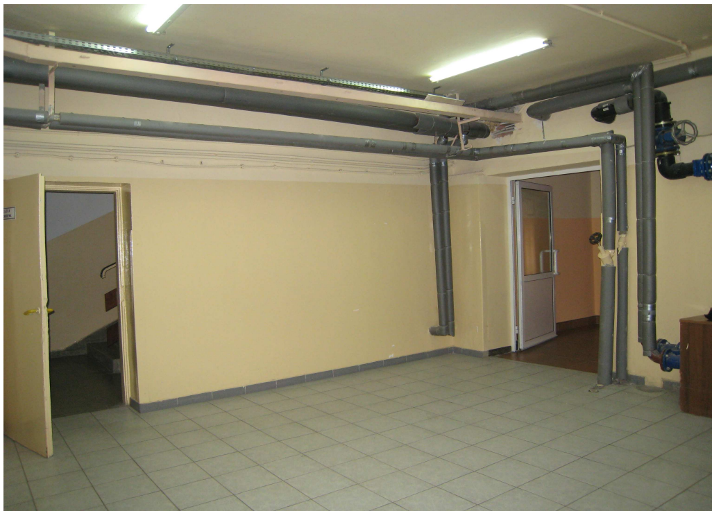
Zdjęcie Nr 1. Przewody do zabezpieczenia przechodzące przez ściany p.poż. w piwnicy.
