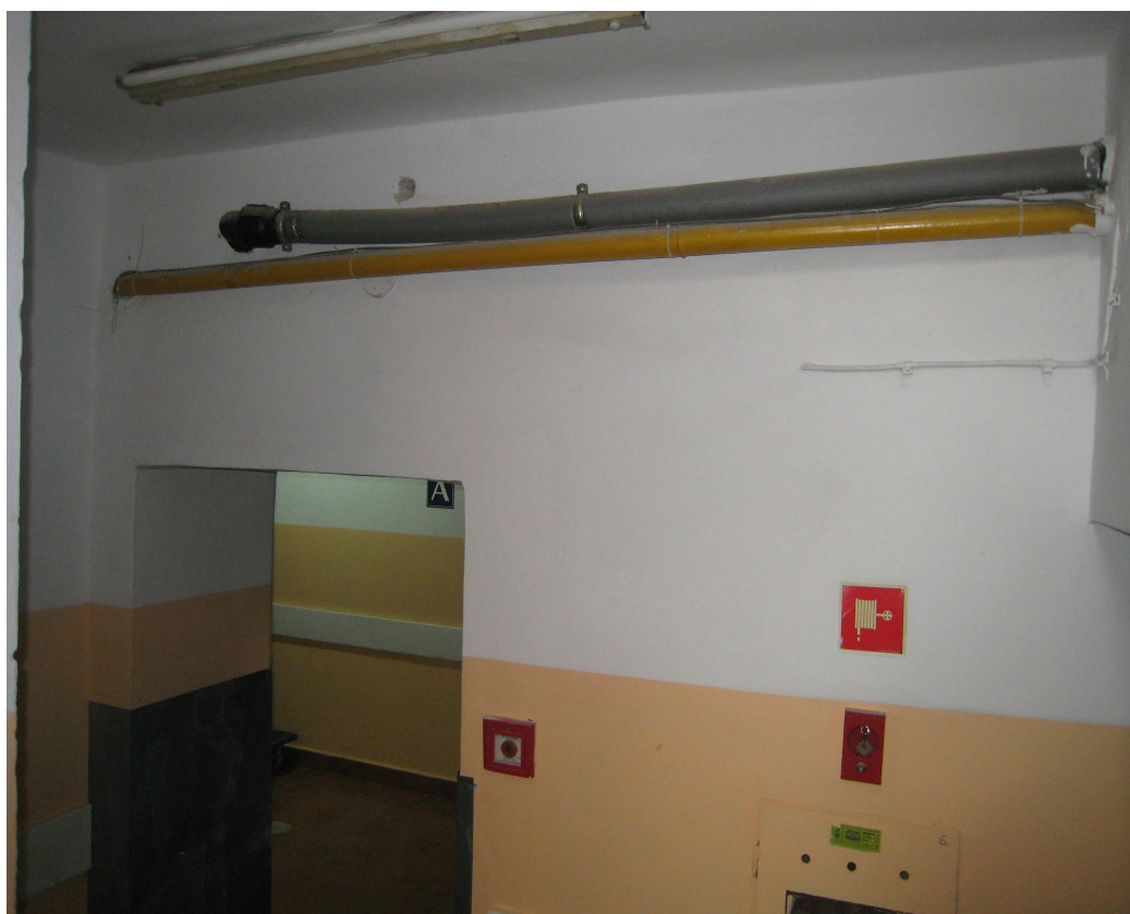
Zdjęcie Nr 2. Przewody do zabezpieczenia przechodzące przez ściany p.poż. w piwnicy.
